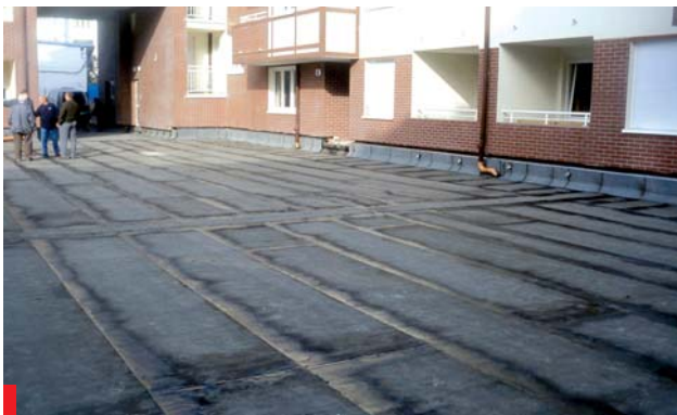
Odbiór hydroizolacji – obróbka dekarcka na ścianę kryje dylatację konstrukcyjną płyty stropowej
