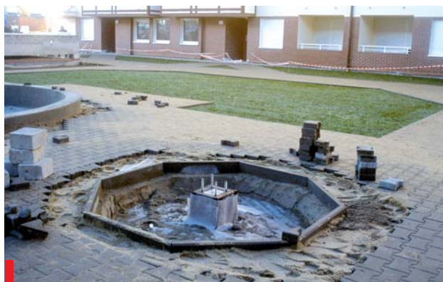
Jedynym elementem „małej architektury” posadowionym bezpośrednio na stropie były podstawy pod latarnie
