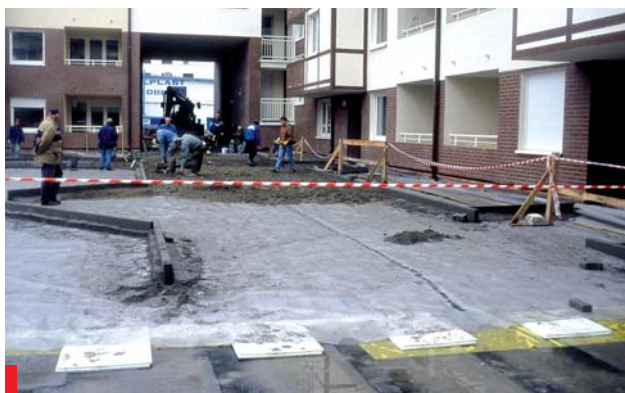
Nawierzchnie drogowe wykonywane były etapami
