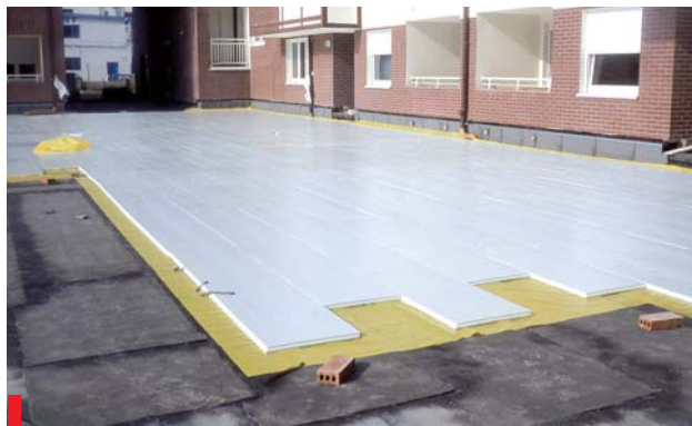
Termoizolacja dachu w układzie odwróconym
