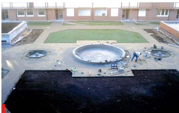
Żelbetowa konstrukcja piaskownicy pojawiła się powyżej warstwy drenażowej
