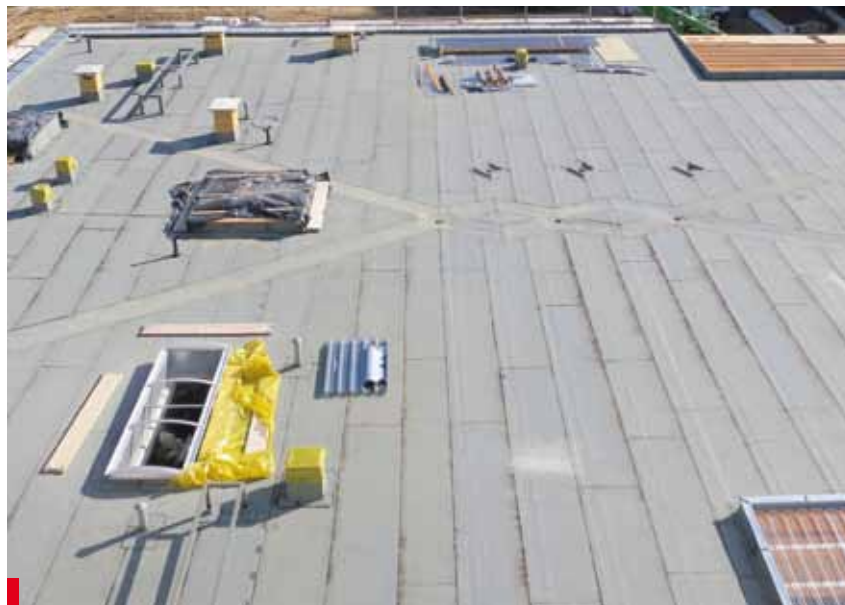
Hydroizolacja dachu pod zieleń
