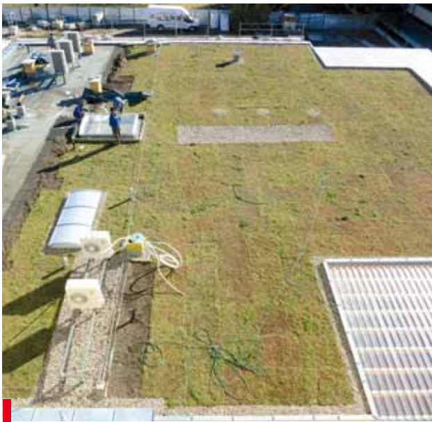
Układanie mat z roślinnością ekstensywną — październik 2012
