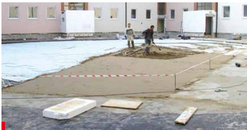
Fot. 2. Jeszcze trwa betonowanie, a wykonawca hydroizolacji już gruntuje warstwę spadkową
