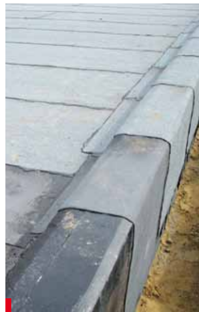
Fot. 5. Koordynacja ze strony kierownictwa budowy jest zbędna, gdy wykonawcą hydroizolacji fundamentów oraz stropu garaży jest ta sama specjalistyczna firma
