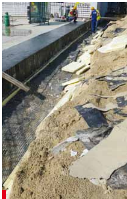
Fot. 4. Zdemontowane materiały zazwyczaj nie nadają do ponownego wbudowania
