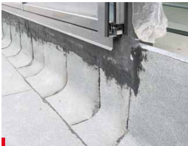
Fot. 11. Na tym dachu prawidłowa kolejność robót została zachowana
